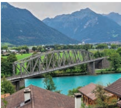
Die grosse Eisenbahnbrücke (Foto: Fritz Keller)
